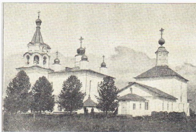
Вид Благовещенского (холодного) собора и Спасской (теплой) церкви в Коряжемском монастыре.
