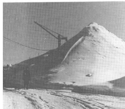
Рытье котлована для фундамента под сульфитно-целлюлозный завод. Январь, 1957 год.
